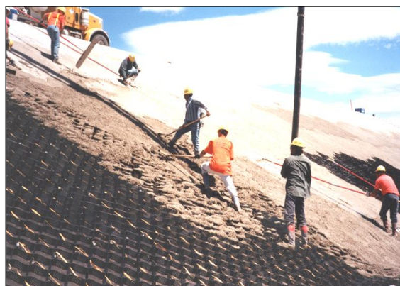
Figura 28: Instalación de geoceldas rellenas de concreto para protección de cara de presa, Gardneville, nevada - USA
