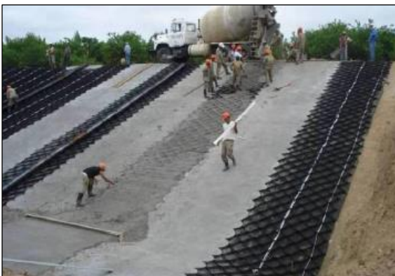
Figura 25: Instalación de geoceldas rellenas de concreto para protección de talud - Tumbes
