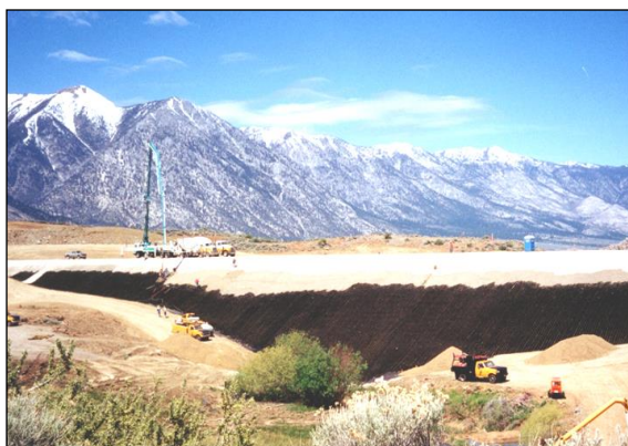
Figura 27: Instalación de geoceldas rellenas de concreto para protección de cara de presa, Gardneville, nevada - USA
