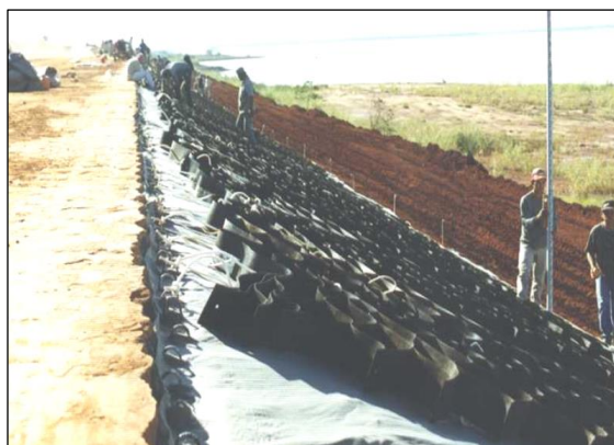
Figura 29: Instalación de geoceldas rellenas de concreto para protección de cara de presa, Mato Grosso do Sul y Rosana, São Paulo - Brasil
