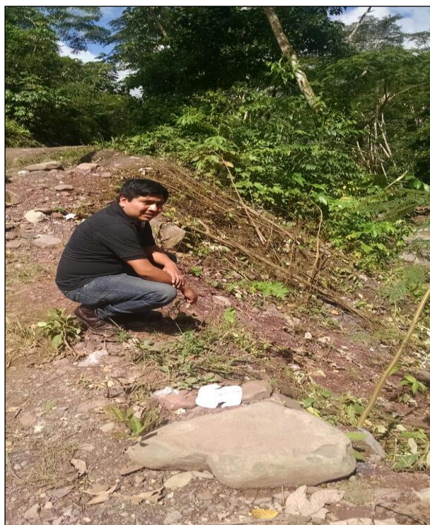
Figura 65: Imagen del talud a defender
